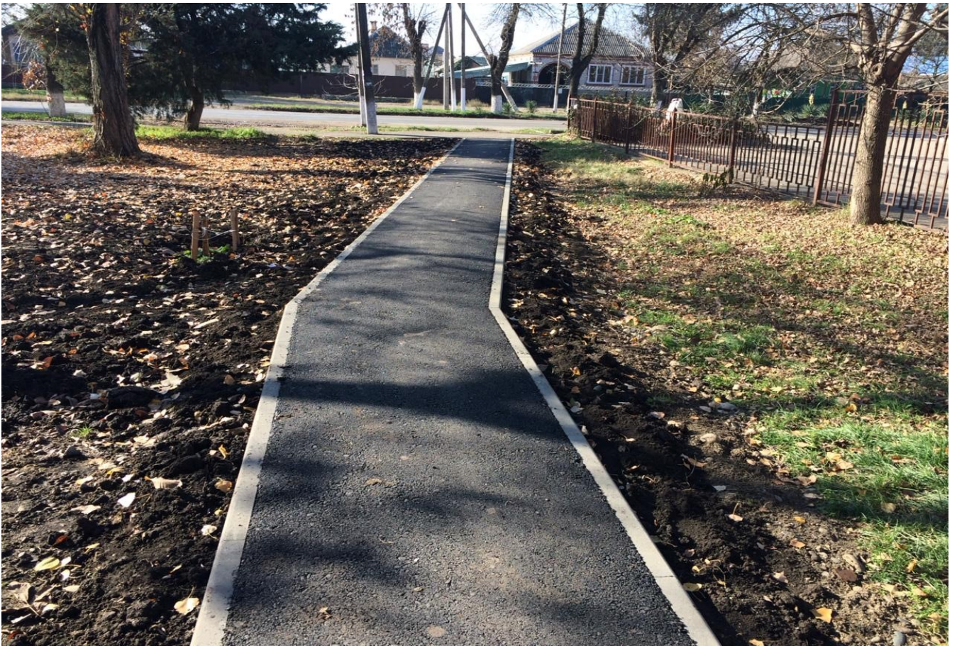
Ремонт тротуаров, пешеходных дорожек
