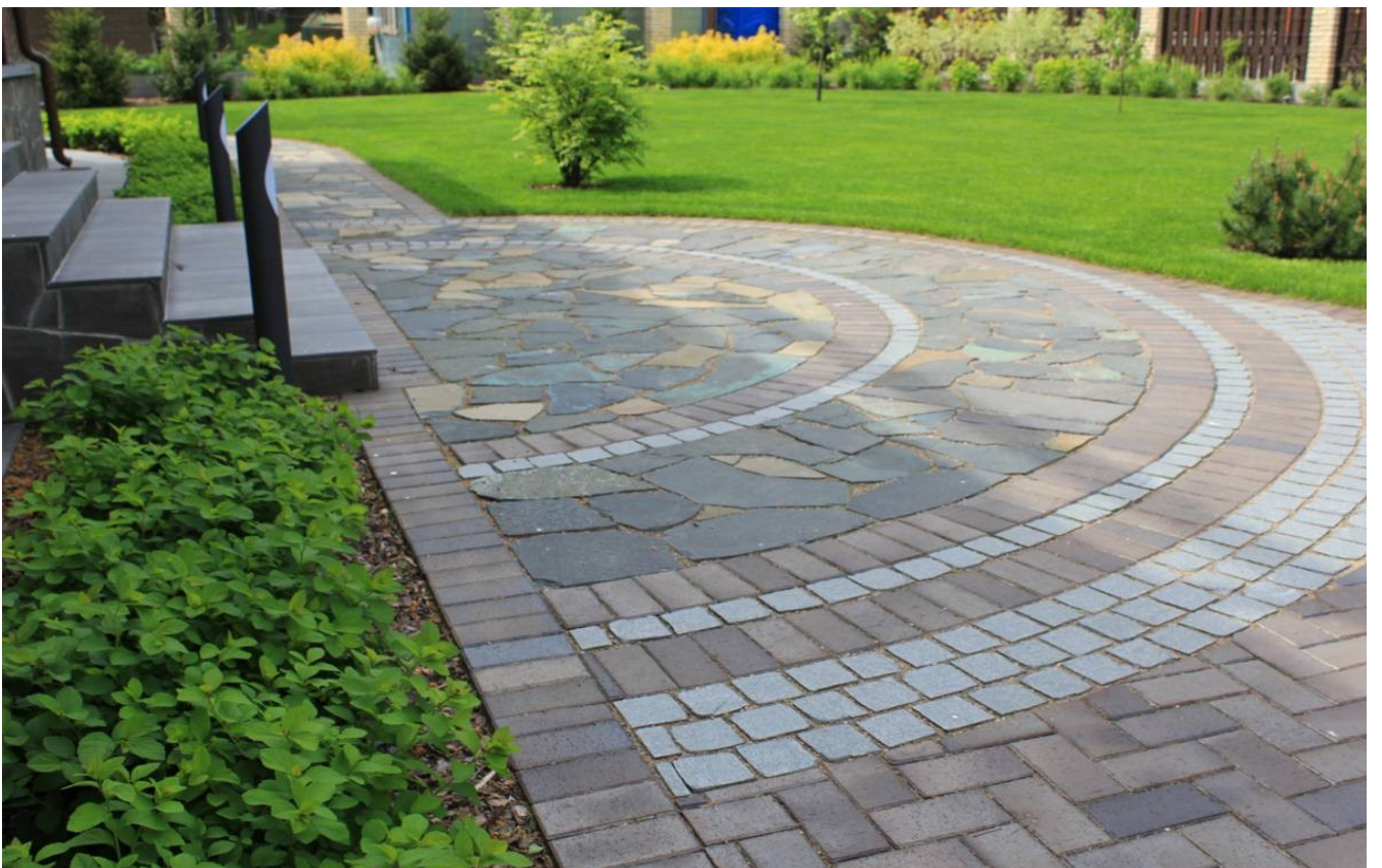
Ремонт твердых покрытий аллей
